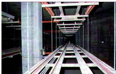
Слика 15. Тунел по кој се движат автоматизирани возила Figure 15. Tunnel for automated vehicles
