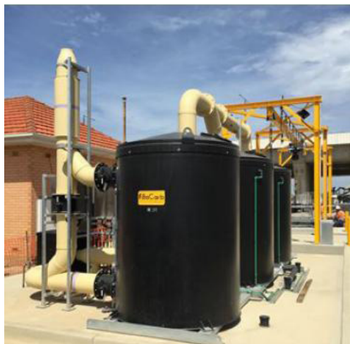
Слика 4. Систем за филтрација со активен јаглен Figure 4. Activated Carbon filtration system
